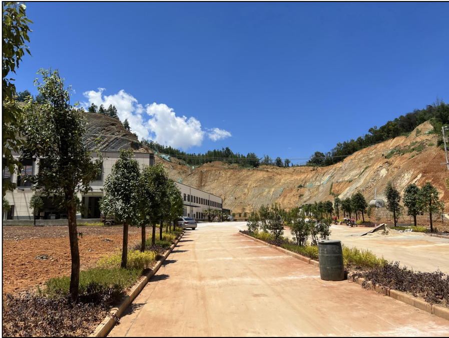
图 5.2-43 项目区外围边坡及厂内硬化层实景图
