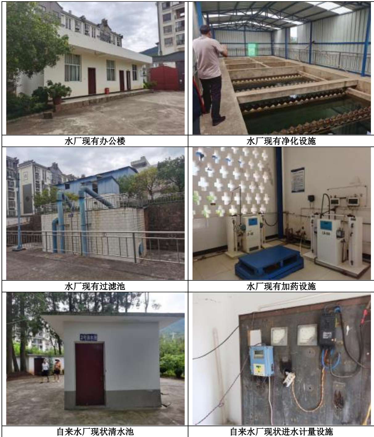
图 2.6-4 武定县自来水厂设施现状
