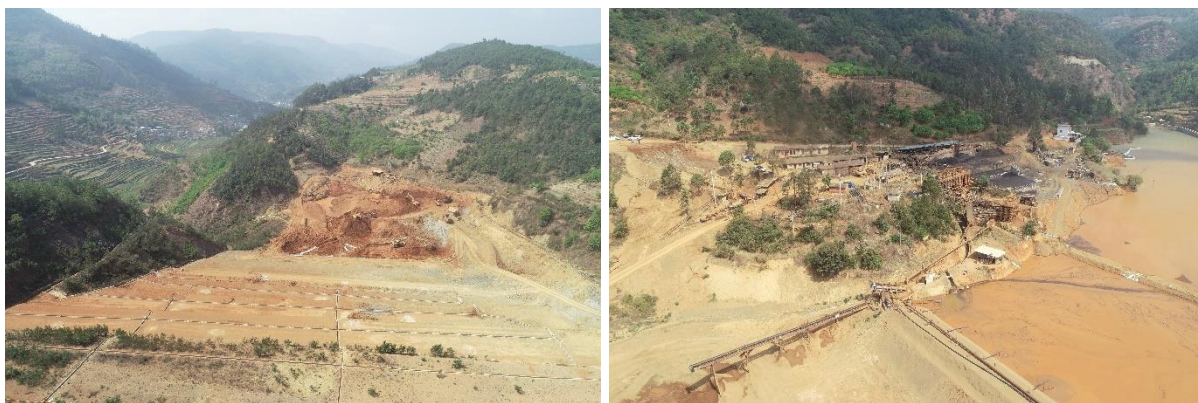
图 2.9-7 武定磐盛钛矿采选厂龙箐尾矿库现状
