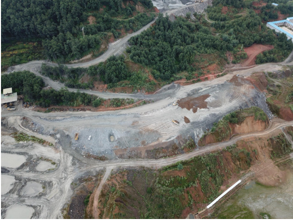
项目区整体现状
