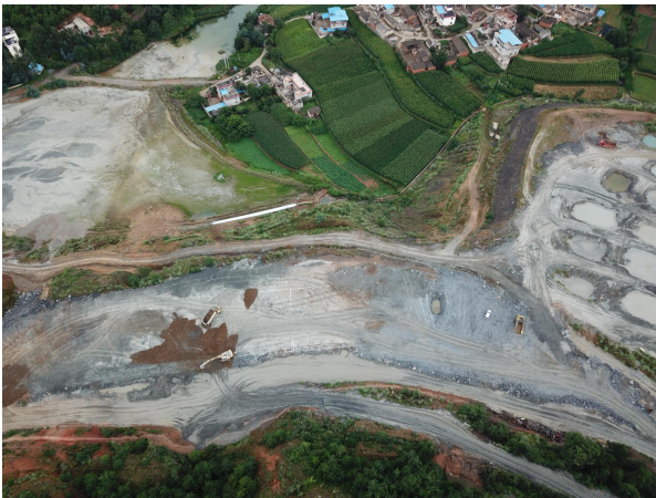
项目区整体现状
