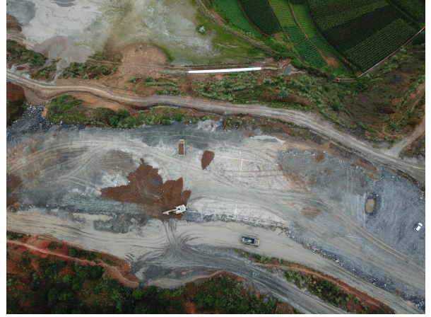
项目区整体现状
